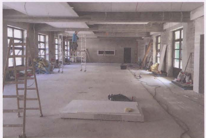
Rohbau des neuen Lesesaals
